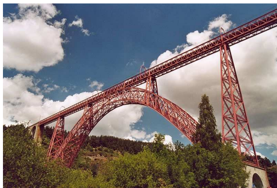
Viaduc de Garabit, Cantal, France
